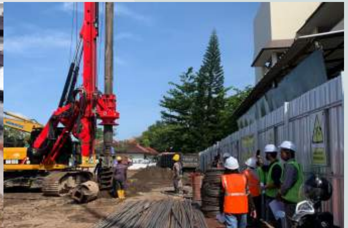
Proses Pembangunan Gedung LRT
