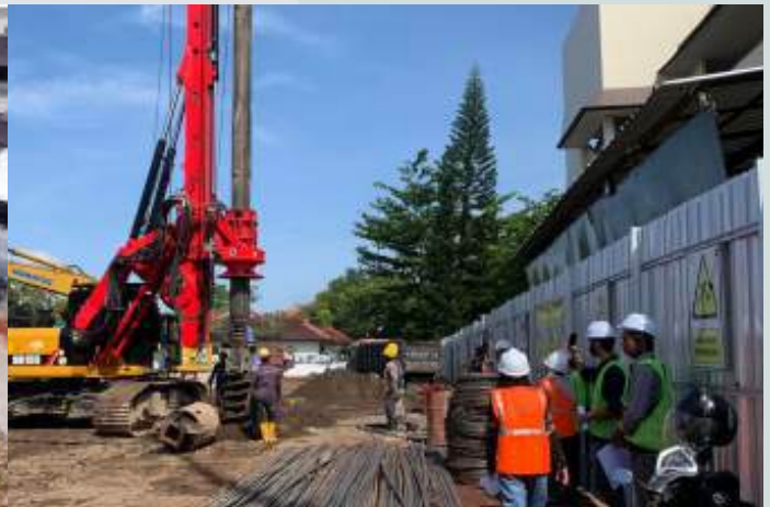
Proses Pembangunan Gedung LRT
